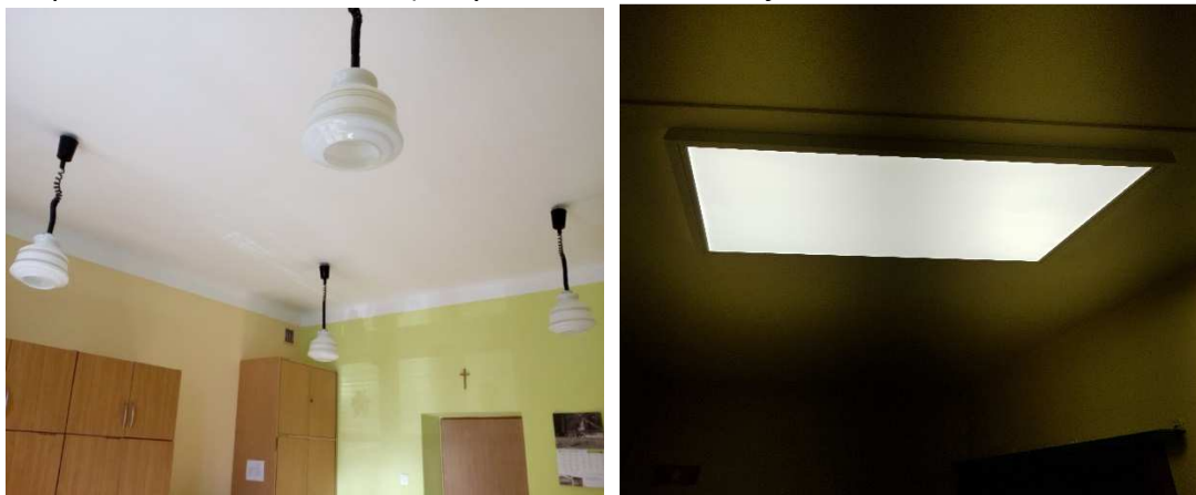
Oświetlenie tradycyjne oraz nowoczesne LED po modernizacji
