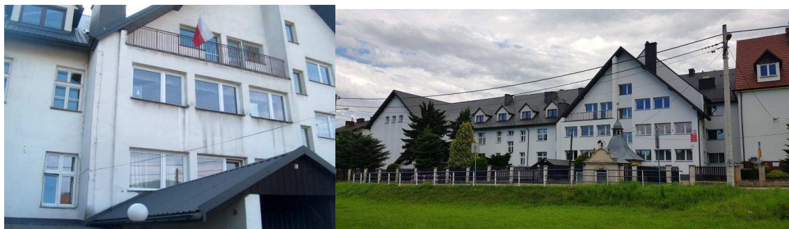
Elewacja budynku wraz z oknami do wymiany przed i po modernizacji.
